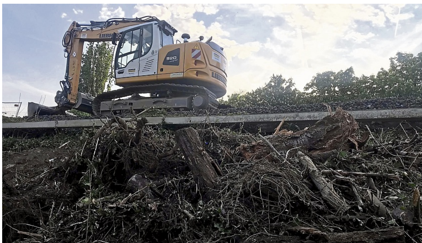
Auf dem Sodener Damm ist schweres Baugerät im Einsatz: Die einspurige Trasse ist komplett gerodet worden und wird für die Regionaltangente West (RTW) ertüchtigt. HOLGER VONHOF
